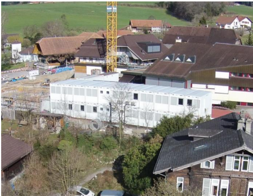
Schulraumprovisorium im Einsatz beim Oberstufenzentrum Wichtrach
