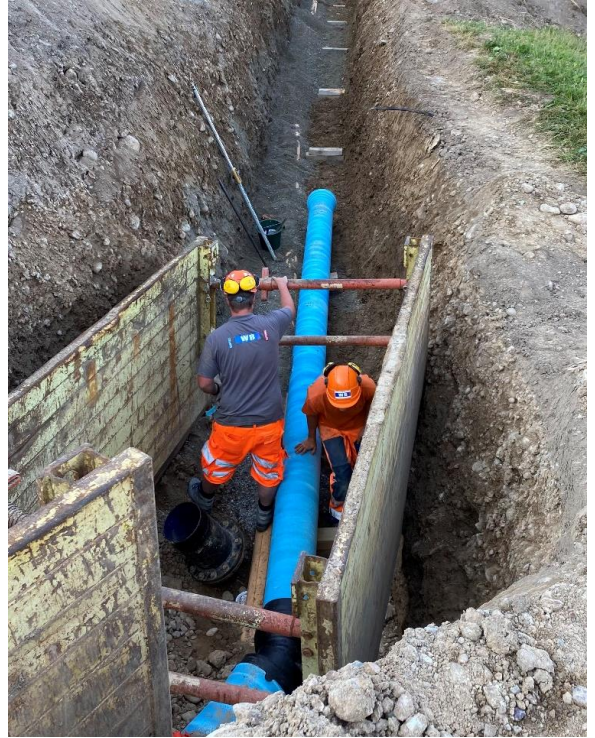
Rohleitungsbau DN 250 aus Duktileisrohr mit Zementmörtel-Umhüllung (Wild AG)
