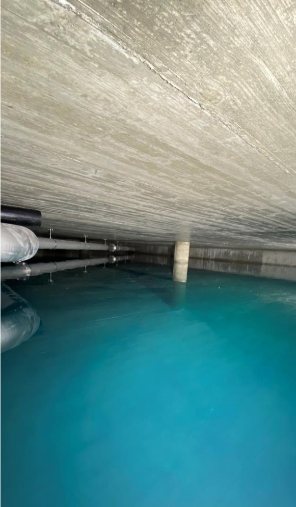
Blick in eine neue Reservoirkammer
