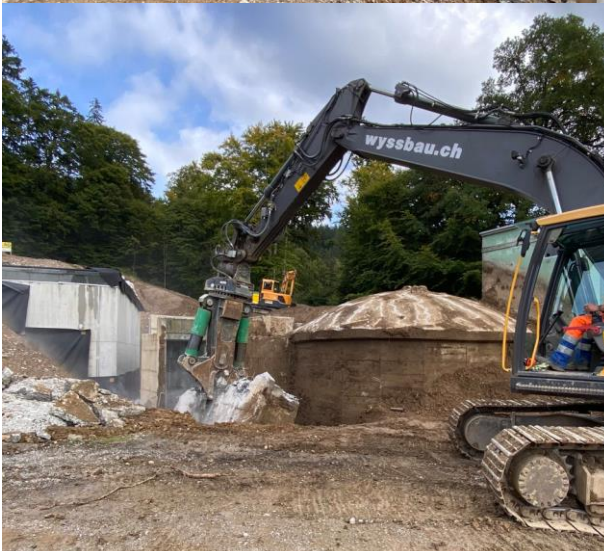
Rückbau des alten Reservoirs, links steht bereits das neue Reservoir
