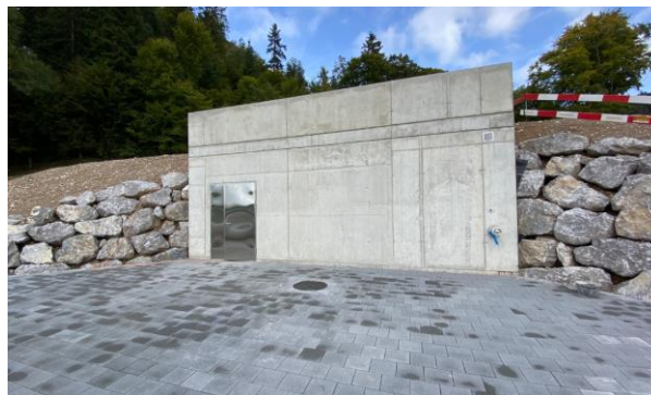
Aussenansicht des neuen Reservoirs
