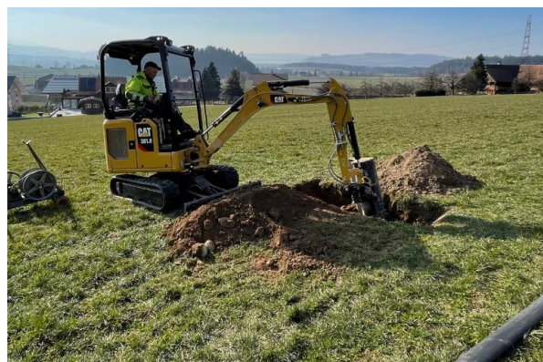
André Zimmermann, Leiter Wassernetz, beim Erstellen des Zugschachts für das LWL – Steuerkabel
