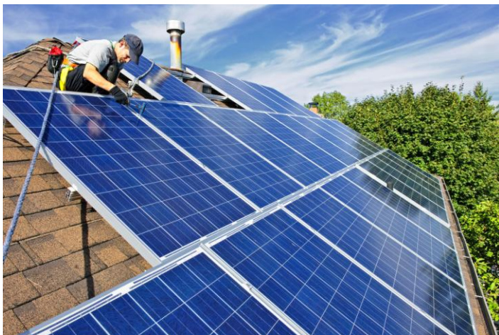
Ab 2014 gelten neue Regelungen für Betreiber von Photovoltaik-Anlagen
